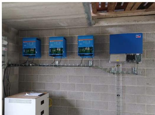
Electrification d'une boucherie totalement autonome sans le réseau électrique de 69 kVA, 29,6 kWc de panneaux photovoltaïques, 30 kWh de batterie Lithium et groupe électrogène de 45 kVA
