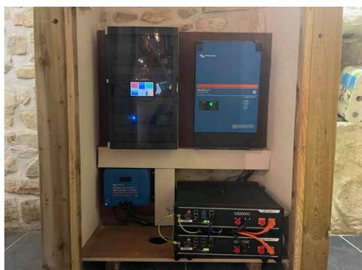
Electrification d'une bergerie dans le sud de la France avec un onduleur de 5 kW, 5 kWh de batterie et 3 kWc de panneaux photovoltaïques sans groupe de secours.
